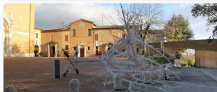
Finestra caduta sui banchi di scuola. Di Baggio presenta interrogazione.
